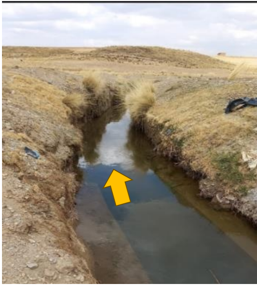
FIGURA N°02: CANAL PRINCIPAL DE ENTRADA Y SALIDA DEL SIFON QUE SE ENCUENTRA COLMATADO DE MATERIAL DE SEDIMENTO (CRUCE DE QUEBRADA)
