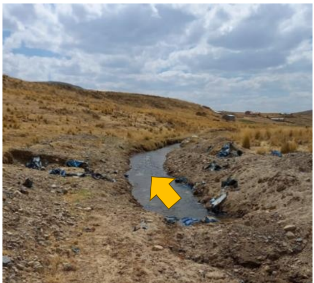
FIGURA N°02: CANAL PRINCIPAL DE ENTRADA Y SALIDA DEL SIFON QUE SE ENCUENTRA COLMATADO DE MATERIAL DE SEDIMENTO (CRUCE DE QUEBRADA)
